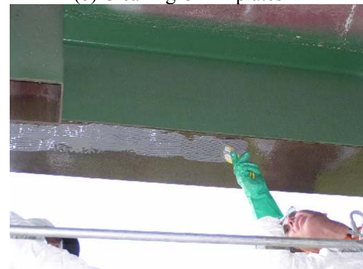
(d) Epoxy application on beam
