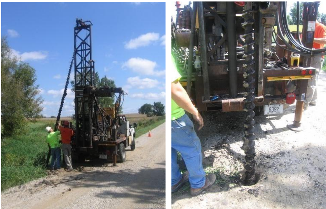
a.) Drilling rig
