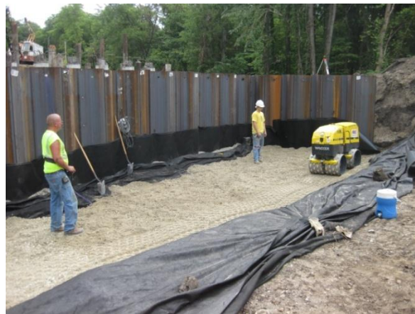
b.) Vibratory compaction
