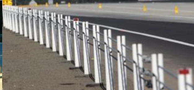
(d) Median cable barrier
